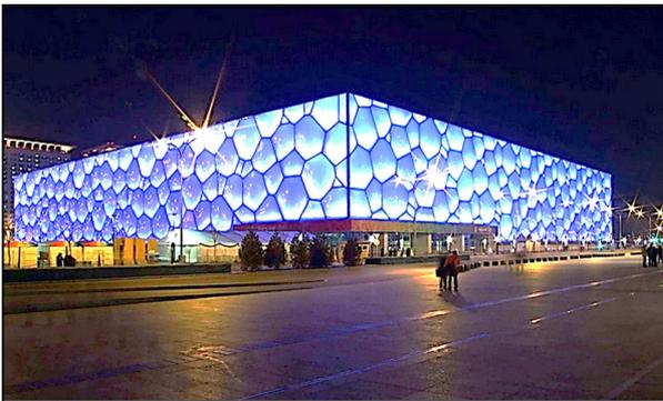
A estrutura metálica configura um imenso prisma ( $177\text{ m} \times 177\text{ m} \times 30\text{ m}$ ) que é vedado e, ao mesmo tempo, revestido por quatro mil painéis pneumáticos de ETFE autoportantes. Um mega empresário chinês sonhou em transformar o Cubo D'Água em uma enorme piscina. "Já que possuímos a maior muralha do mundo, também teremos a maior piscina.", afirmou o empresário.
